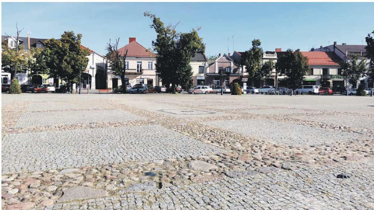
Nowy Rynek w Łowiczu coraz bardziej przypomina betonową pustynię.
