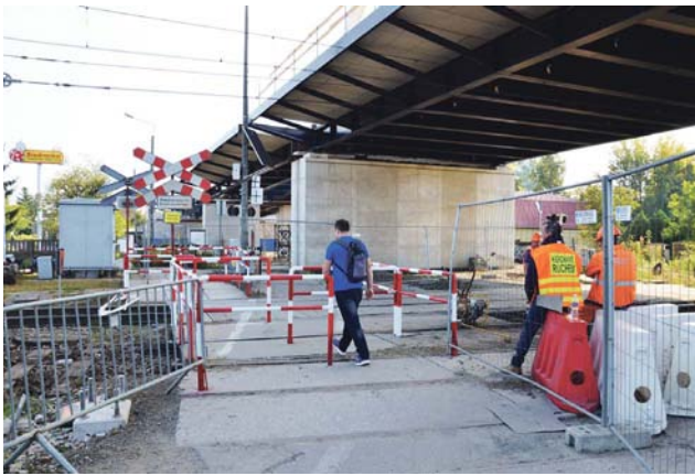
Na przejściu przez tory na ul. 3 Maja w Łowiczu zamontowany został tzw. labirynt po to, aby pieszy nie wbiegł pod pociąg.
