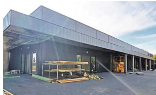
Prace przy przebudowie marketu są już zaawansowane.
