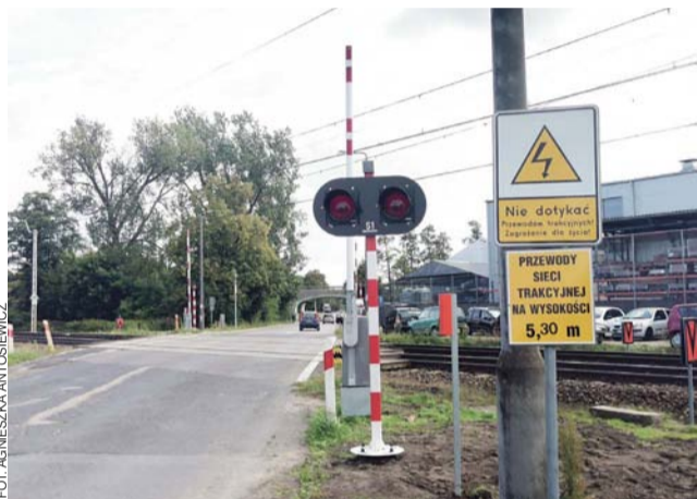
Dotychczasowe półrogi zostały zastąpione przez rogatki typu „A”, czyli takie, które zamykają całą szerokość jezdni.
