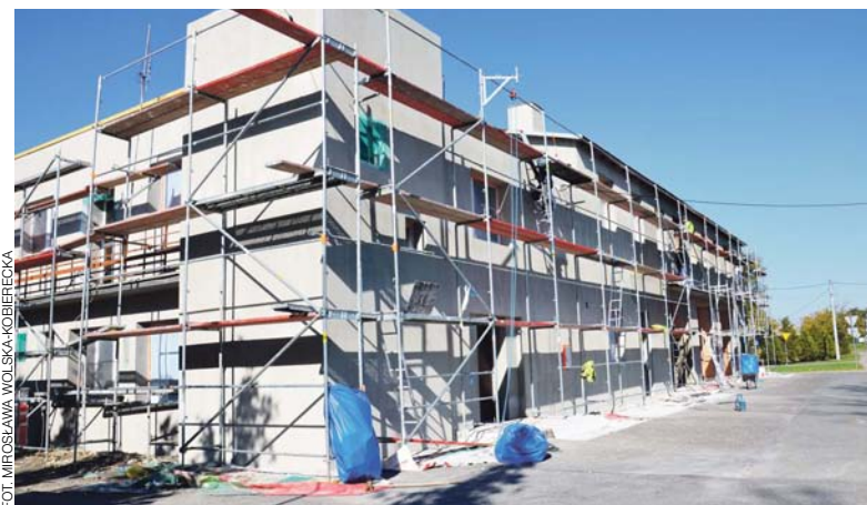
Nawet w trakcie prac, jeszcze z rusztowaniami strażnica OSP w Zdunach wygląda znacznie lepiej niż przed remontem.
