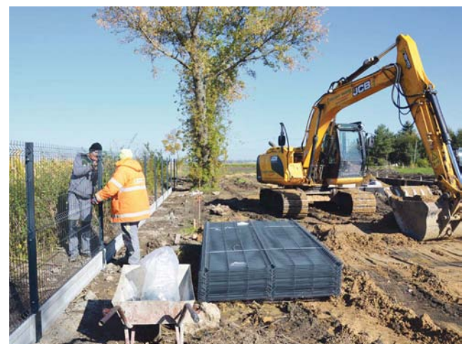
Gdy odwiedziliśmy plac budowy w Jackowicach, prowadzone były prace przy budowie biegni i montowano ogrodzenie boiska.
