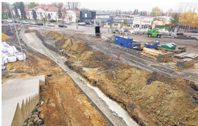
Widok na wiadukt na budowę ul. Napoleńskiej, w tle Urząd Poczty Polskiej i ul. 3 Maja.
