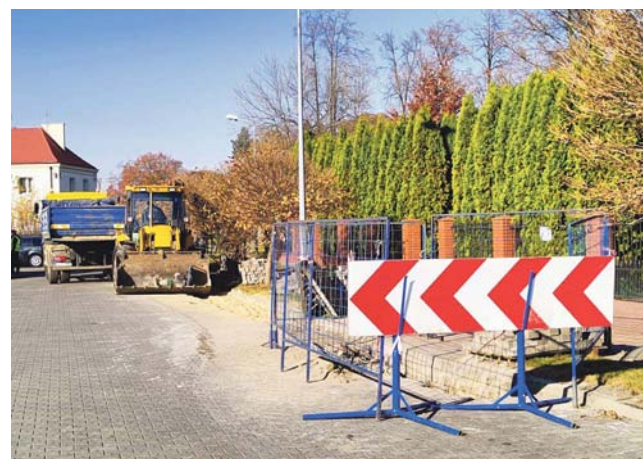
Miasto rozpoczęło pracę nad tymczasowym przyłączeniem posesji przy Piekarskiej pod koniec października.
