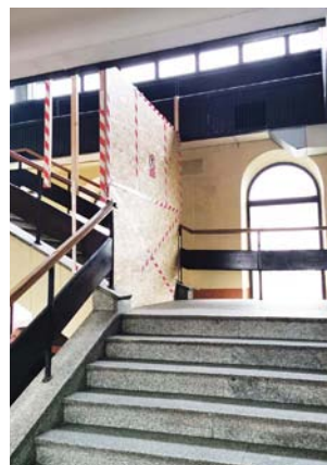
Na schodach wiodących na piętro dworca pojawiła się ściana – zapowiedź remontu.
