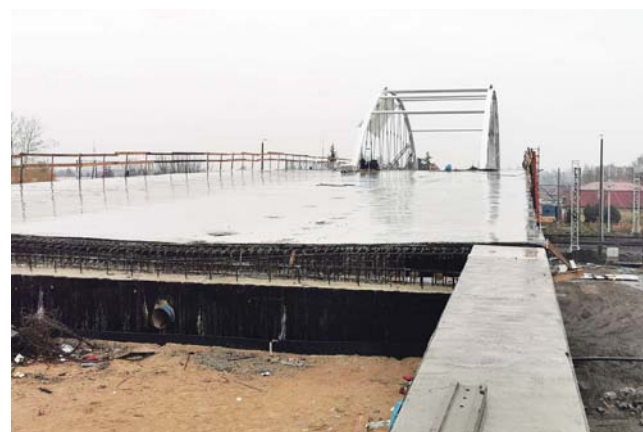
Widok na wylaną już betonową płytę wiaduktu od strony południowej.
