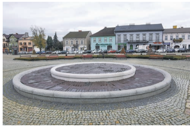
Fontanna na Nowym Rynku została już wyłączona. Możliwe, że w przyszłym roku doczeka się remontu.
