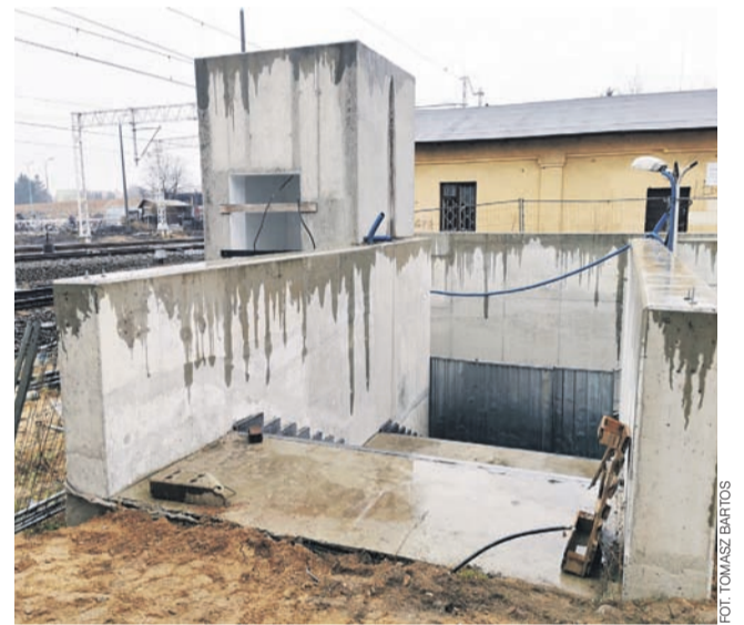
Wysoki obiekt przy przejściu podziemnym to jeden z szybów na windę.
