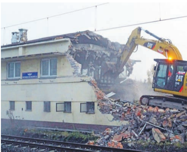
Wyburzenie nastawni na Dworcu PKP Łowicz Główny.
