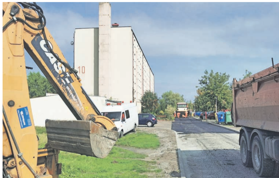
Według planów, blok ma powstać w miejscu, gdzie nadal jest stara kotłownia (parterowy budynek przed istniejącym blokiem, za białą furgonetką).
