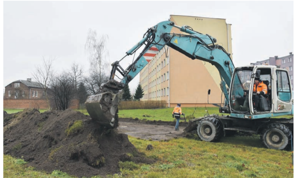
Prace ziemne rozpoczęły się w ubiegłym tygodniu
