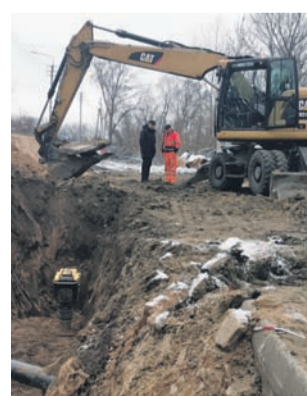
Aktualnie pracownicy Trakt realizują uzbrajanie w media łącznika ul. Nieborowskiej i Dworcowej, w dalszej kolejności zostanie tam wykonana podbudowa i nawierzchnia.
