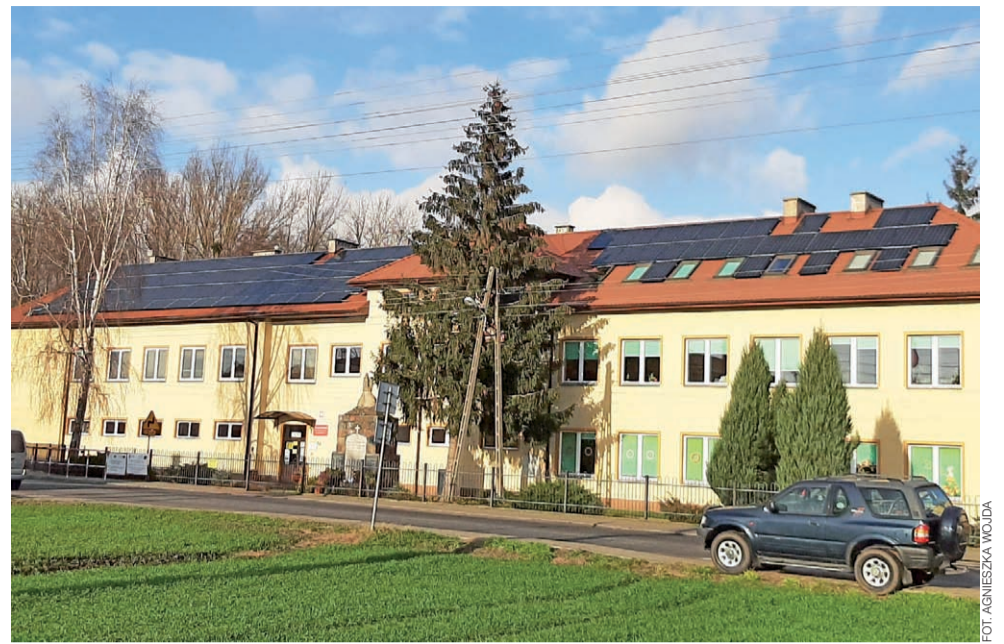
Instalacja fotowoltaiczna została wykonana na budynku szkoły w Kocierzewie Północne, a także dwóch innych szkołach i Urzędzie Gminy.
