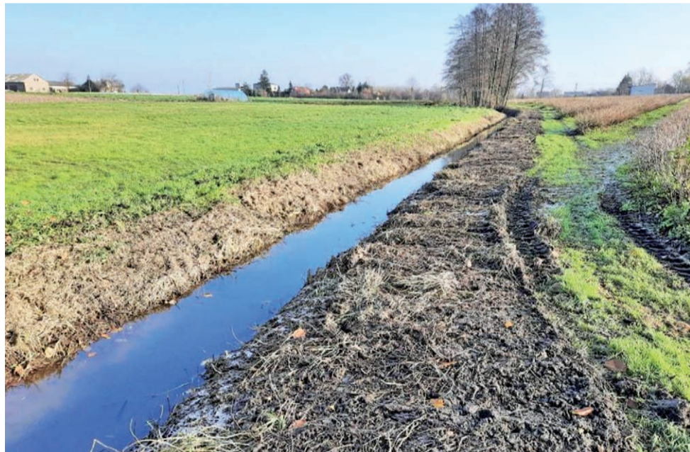
Dzięki staraniom Gminnej Spółki Wodnej w minionym roku konserwacji poddanych zostało kilkanaście rowów melioracyjnych na terenie całej gminy.
