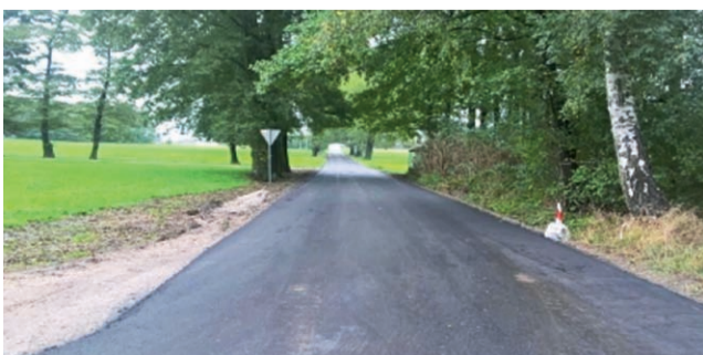
Wyremontowana droga gminna w Czatonie (gmina Łyszkowice).
