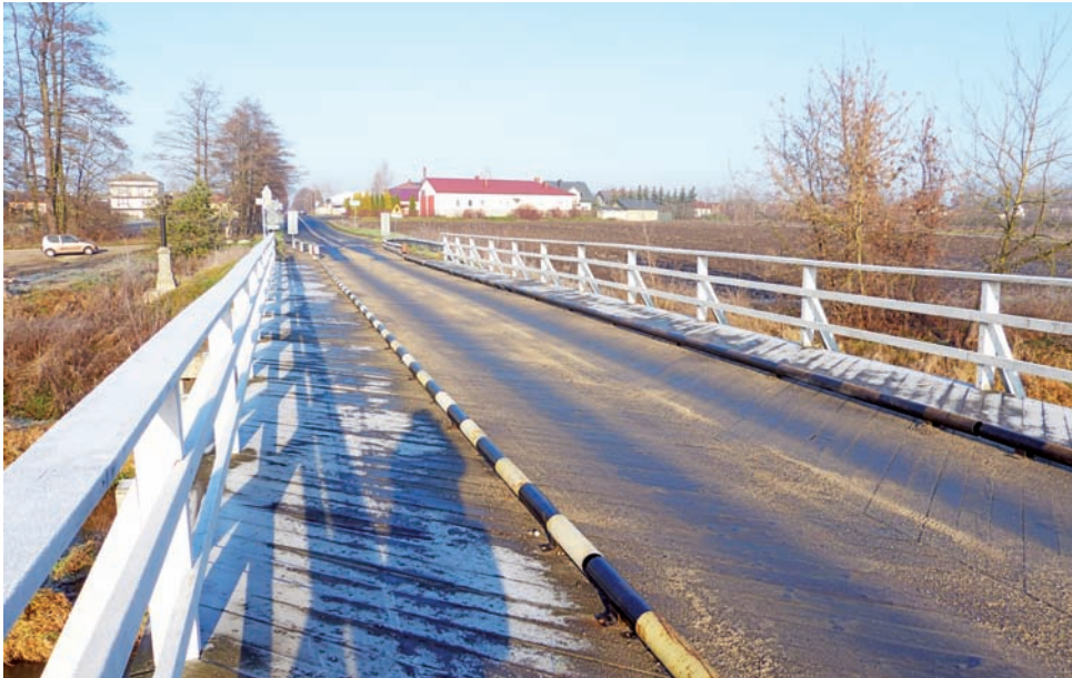
Największym przedsięwzięciem, jakie powiat łowicki chciałby zrealizować w tym roku, jest budowa nowego mostu na Bzurze w Kompinie. Jego koszt szacowany jest na kilkanaście milionów.
