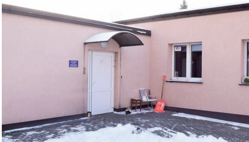
Dawniej była to siedziba MOPS. Obecnie budynek pełni funkcję noclegowni.
