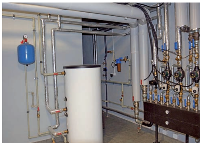
Zmodernizowana została cała sieć rozpraszająca ciepło w budynkach.
