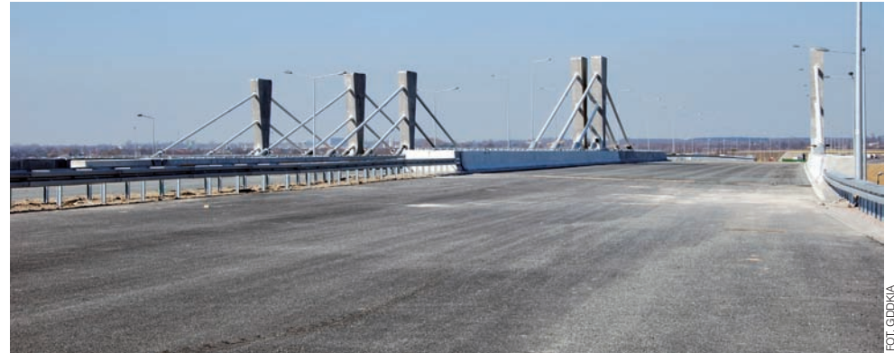
Od razu po stwierdzeniu pęknięć wiadukt został wyłączony z ruchu.
