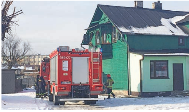
Strażacy szybko opanowali sytuację, choć mieszkańcy przeżyli chwile grozy podczas pożaru instalacji elektrycznej.
