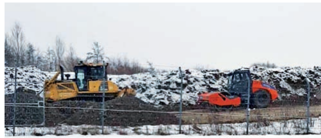
Na działce rozpoczęły się już pierwsze prace przygotowujące teren pod nową inwestycję.
