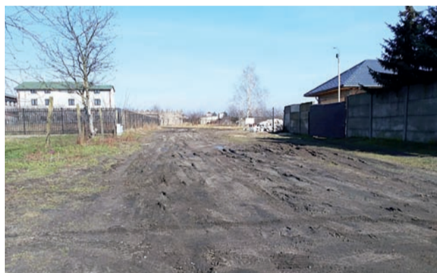
Widok na ul. Cebertowicza w Głownie. Czy w tym miejscu w przyszłości pojawią się lampy uliczne?
