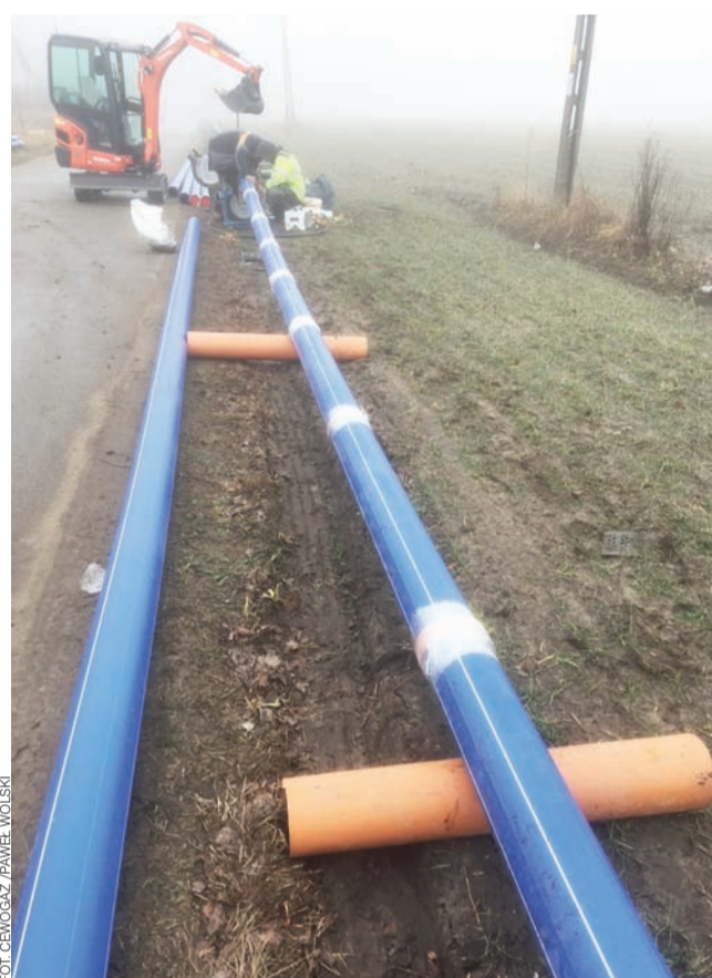
Rury z polietylenu, którymi popłynie woda między Bednarzami a Kompina, są łączone metodą zgrzewania.
