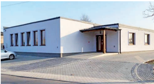
Budynek świetlicy w Szczecinie.
