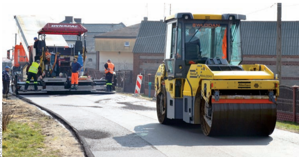
Prace drogowe na drodze Popów – Mięsośnia – Waliszew.
