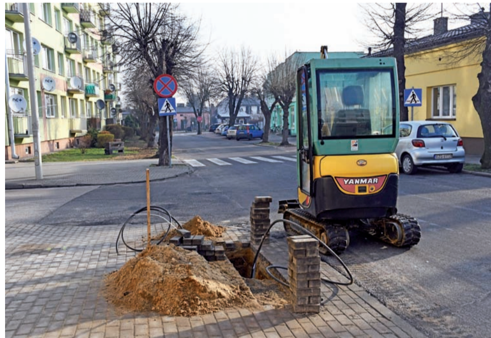
Budowa oświetlenia przy ul. Emilii Plater w Strykowie.
