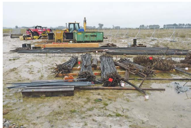
Opuszczony plac budowy w Piaskach Bankowych.
