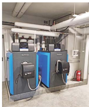
Nowa kotłownia w Bratoszewicach.
