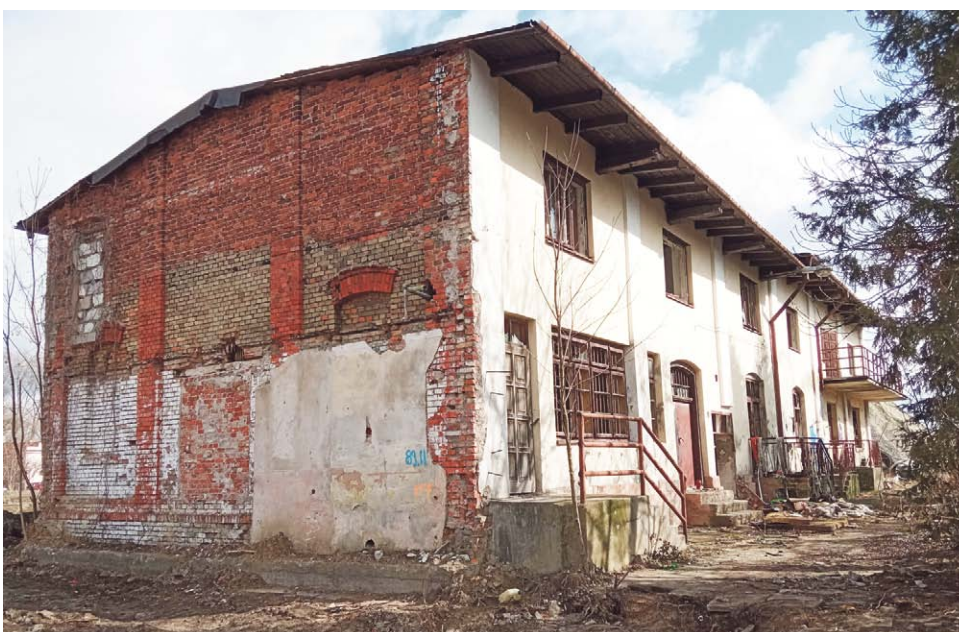
Stary opuszczony budynek w sąsiedztwie nowej, świeżo wyasfaltowanej ulicy, to widok co najmniej groteskowy.
