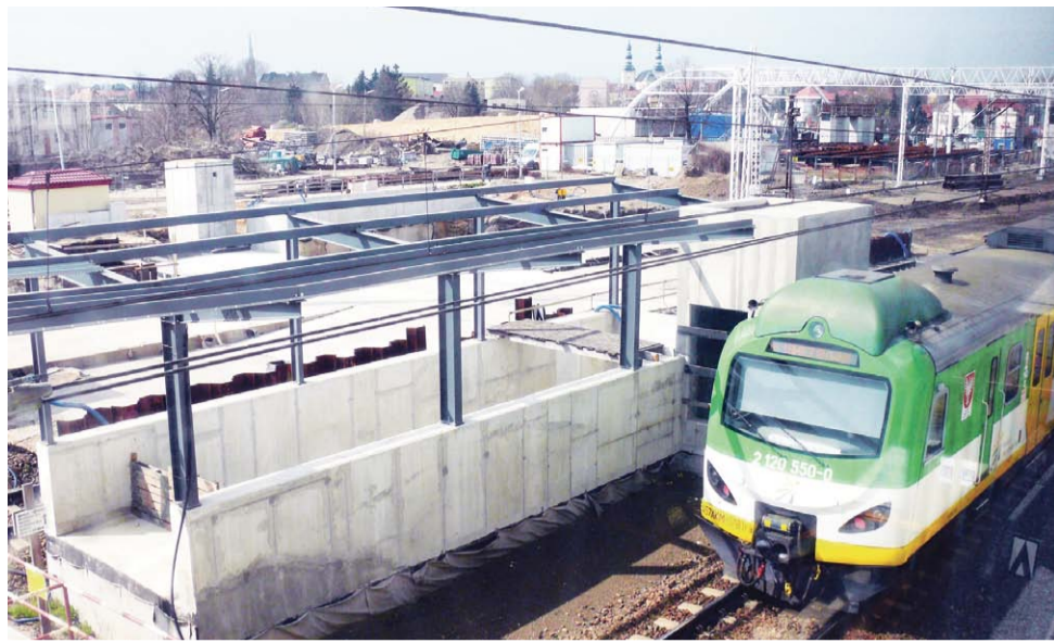
Widok na powstające przejście podziemne z piętra budynku dworca.
