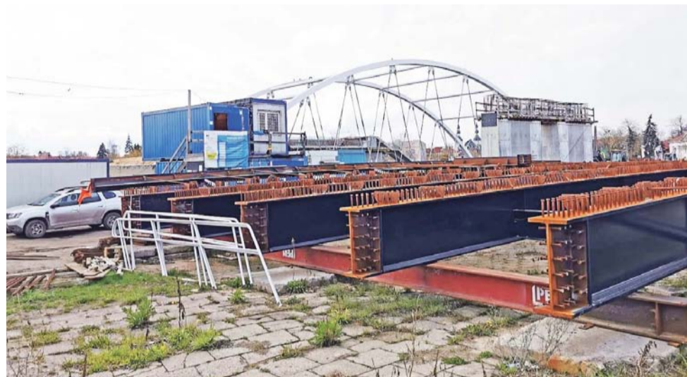
Prawdopodobny termin ustawienia na filarach konstrukcji wiaduktu, gotowej przecież już od dawna, to przełom czerwca i lipca.
