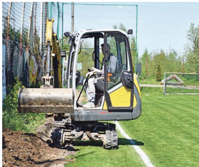
Prace przy budowie oświetlenia powinny zostać zakończone do końca maja.
