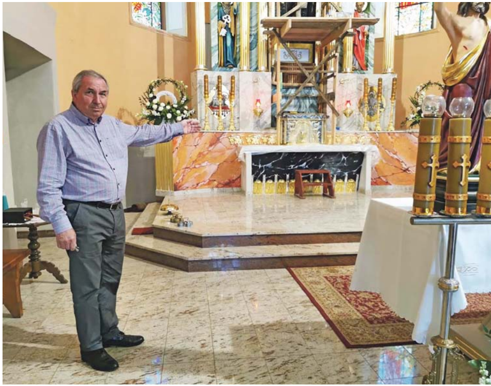
W trakcie renowacji jest te ołtarz głwny kościoła w Łyszkowicach.
