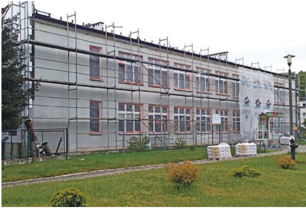
Teren Miejskiego Przedszkola nr 3 w Głownie zamienił się już w plac budowy.
