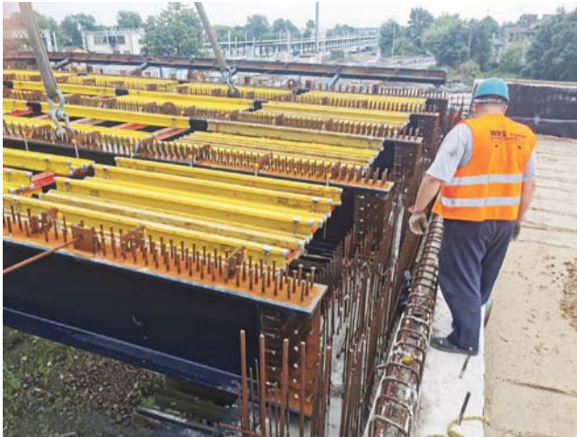
Przęsła już osadzone na podporach.
