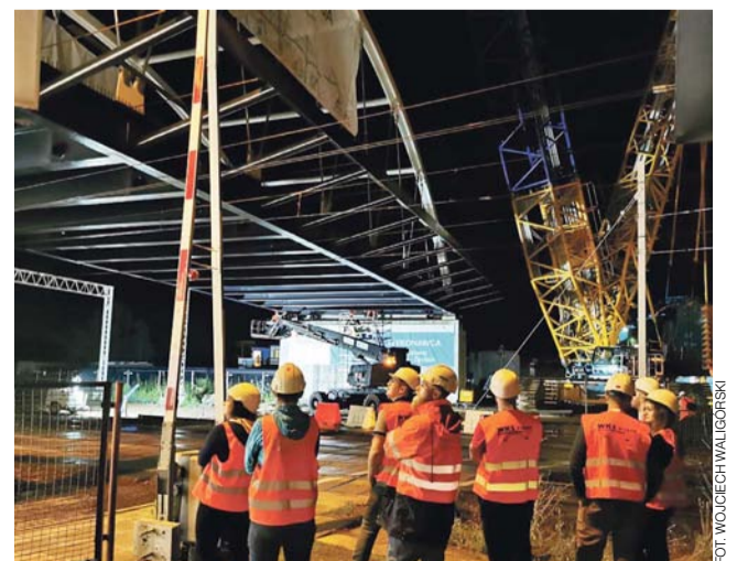
Faza ostatnia: konstrukcja jest osadzona na podporach.
