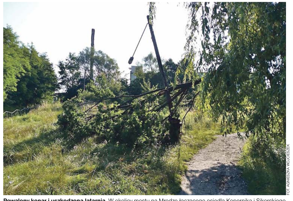
Powalony konar i uszkodzona latarnia. W okolicy mostu na Mrodzie łączącego osiedla Kopernika i Sikorskiego w Głownie zrobiło się zupełnie ciemno, więc przejście wieczorem tą popularną trasą nie należy do przyjemnych.
