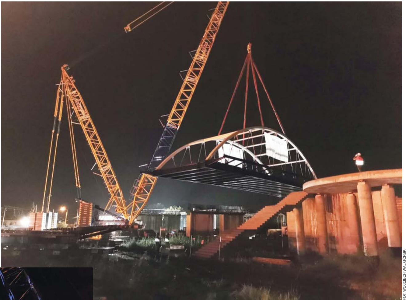
Pierwsze minuty operacji – główne przęsło z wiaduku uniesione z miejsca, w którym było składowane.
