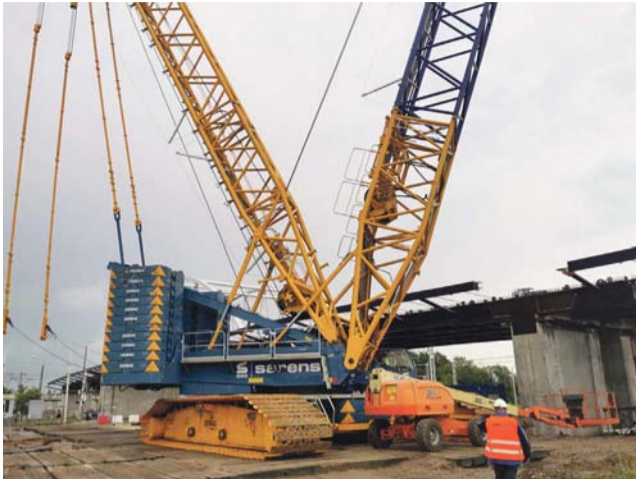
Głównym „pracownikiem” podczas montażu był ten gigantyczny dźwig na gąsienicach.
