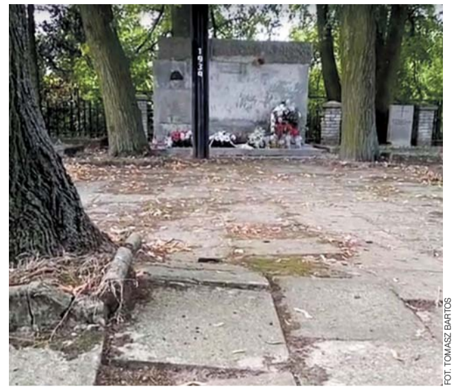
Cmentarz wojenny w Kompinie – na pierwszym planie krzywy chodnik z betonowych płyt, w tle płyta głównego pomnika.
