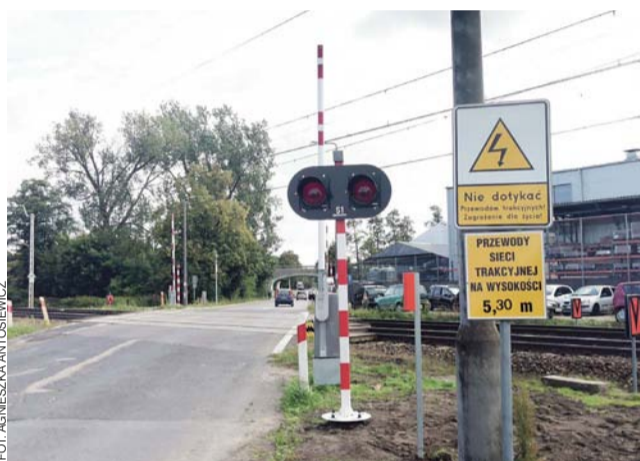
Dotychczasowe półrogatki zostały zastąpione przez rogatki typu „A”, czyli takie, które zamykają całą szerokość jezdni.
