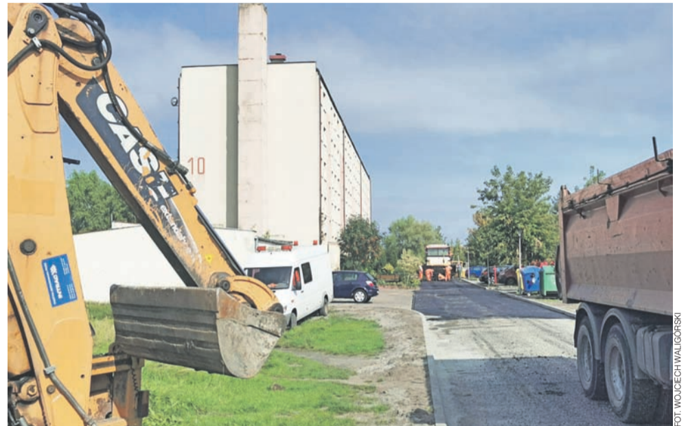
Według planów, blok ma powstać w miejscu, gdzie nadal jest stara kotłownia (parterowy budynek przed istniejącym blokiem, za białą furgonetką).
