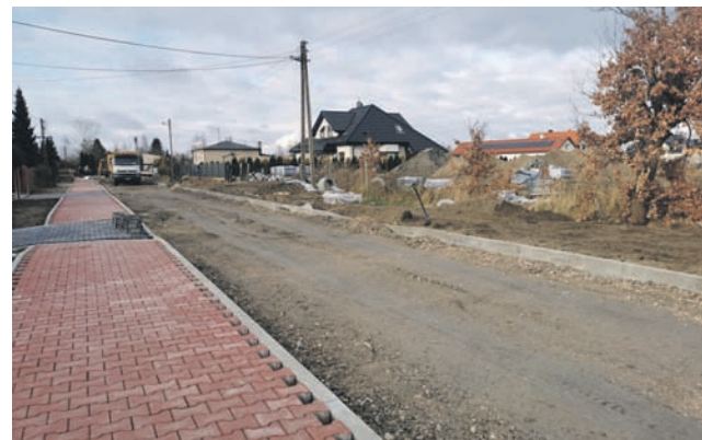
Chodnik już jest wykonany, ale ulica cały czas pozostaje nieprzejezdna.
