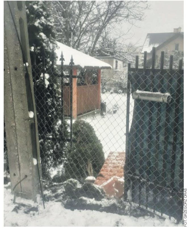
Zniszczony fragment ogrodzenia po ostatniej kolizji w tym miejscu.
