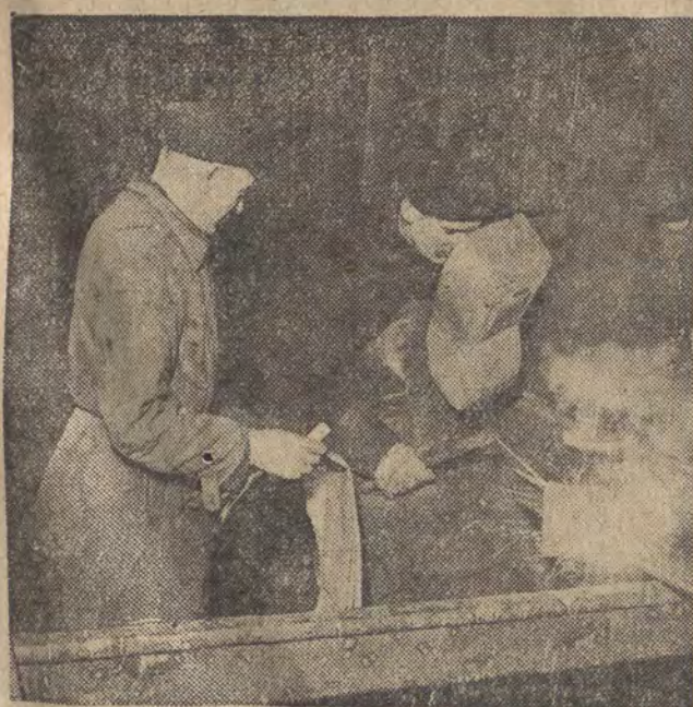
W grudniu 1953 r. wysłano z huty „Zabrze” około 1000 ton konstrukcji dla potężnej hali nowohutnickiej siłowni. Była to reszta dostaw dla pierwszego etapu budowy siłowni. Załoga huty „Zabrze” przoduje już od szeregu miesięcy w dostawach urządzeń dla Nowej Huty, wykonując je przedterminowo i umożliwiając w ten sposób budowniczym kombinatu zachowanie ciągłości pracy oraz przyspieszając termin jego uruchomienia.
