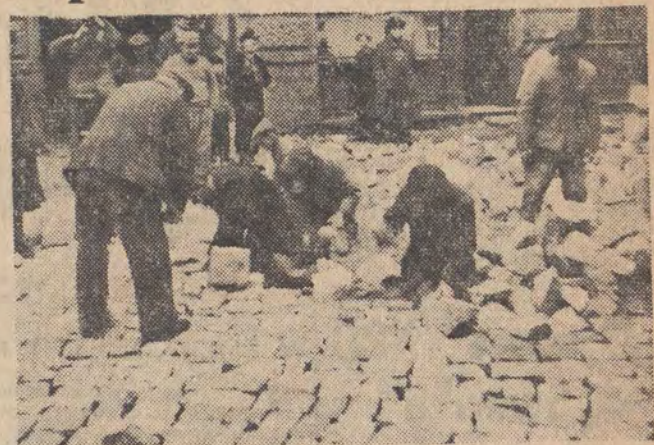
Na zdjęciu: układanie nowej nawierzchni z kostki na ul. Gdańskiej na odcinku od Obrońców Stalingradu do Ogrodowej.
