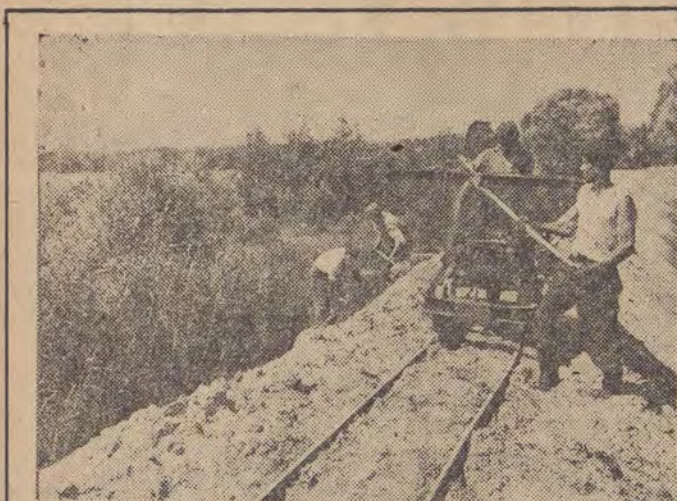
Szeroką tyralierą ruszyła ofensywa na kuwaskie bagna. Na zdjęciu: budowa grobli koło Jeziora Rajgrodzkiego. (Patrz artykuł obok)
