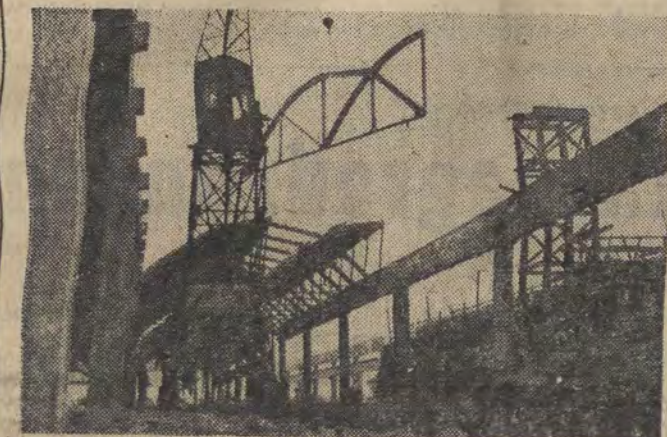
Rozbudowa Fabryki Samochodów Ciężarowych w Lublinie.
