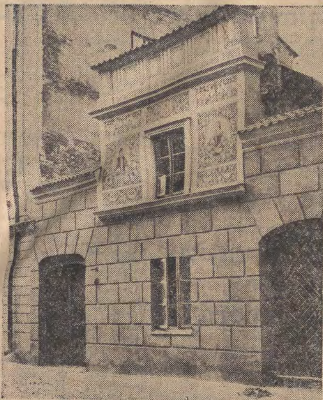
Odbudowana kamienica „Złotników” na Starym Mieście
