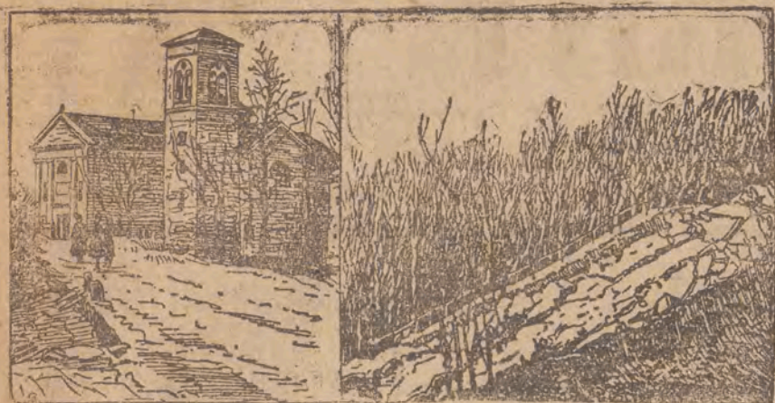
Nienaruszony gmach kościoła. — Zupełnie zniszczona ulica.
