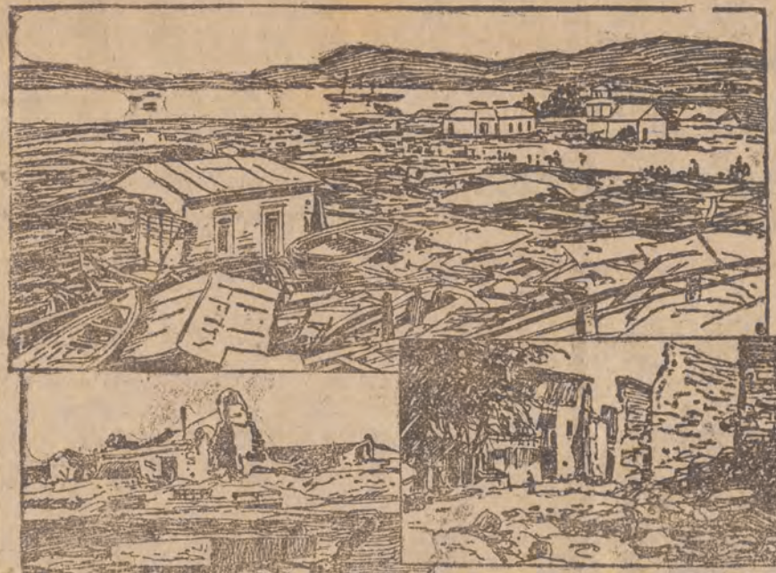
I. Ruiny miasta Baguedano. II. Zniszczone domy w Baguedano. III. Ulica w Coquimbo.
