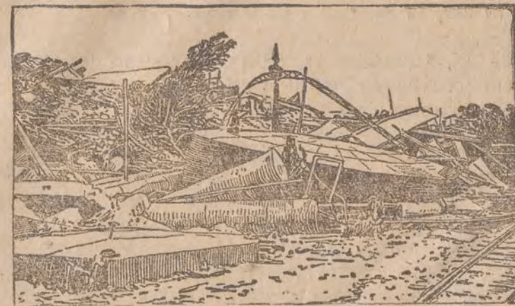
Ołbrzymi zbiornik gazu w mieście Kayama niemal zupełnie zapadł się pod ziemię.
