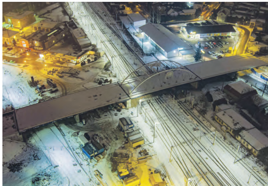
„Przeprawa stulecia”, czyli wiadukt powstający nad torami przy Dworcu Głównym w Łowiczu.
