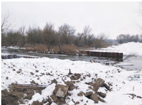
Miejsce budowy mostu na Bzurze w Kompinie. Widoczne są ślasy Larsena, wbite w dno rzeki w miejscu, gdzie powstanie jedna z podpór.
