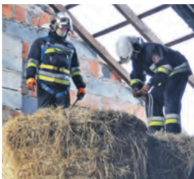
Zabezpieczanie dachów na stodołach przez strażaków.
