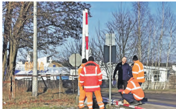
Naprawa rogatek kolejowych, które zostały uszkodzone przez samochód osobowy.
