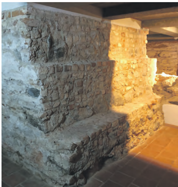
Realizacja prac w kryptach bazyliki była możliwa dzięki pieniądżom z Ministerstwa Kultury i Dziedzictwa Narodowego.
