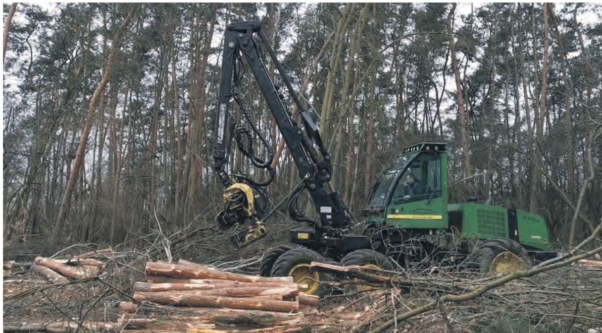
Kombajn drzewny podczas prac w rejonie lasu bliskim torów kolejowych do Głowna.
