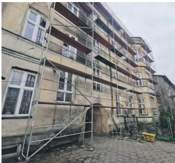
Rusztowania już stoją, posłużą wykonawcy do położenia nowej papy na dachu oraz odkucia fragmentów odpadającego tynku.
