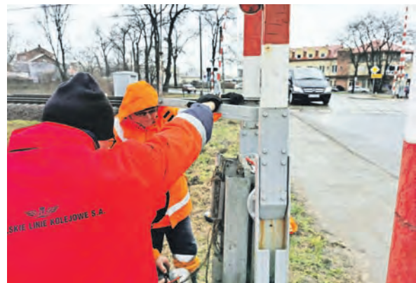
Technicy PKP PLK w czasie przeglądu rogatki na ul. Mostowej.
