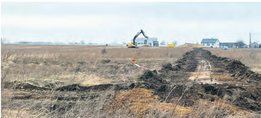
Zdjęcie z ubiegłego czwartku – dnia, kiedy na placu budowy pojawił się pierwszy sprzęt.
