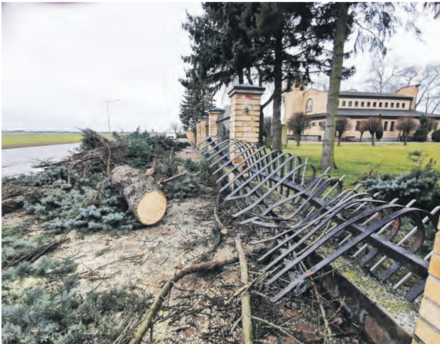
Zniszczone ogrodzenie kościoła p.w. Świętego Rocha w Boczkach Chełmońskich – porywisty wiatr rzucił na przęsto złamany świerk.
