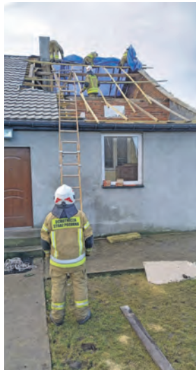
Interwencja druhów z OSP Karsznice Duże na uszkodzonym dachu budynku w Osinach.
