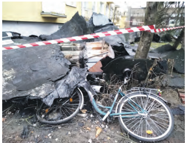
Zerwany, pod wpływem silnego wiatru, dach z bloku 3c na Bratkowicach w Łowiczu uszkodził rower.
