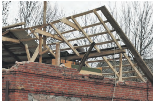
Zniszczony dach na budynku gospodarczym w Kocierzewie Północnym, wiatr zerwał blaszane poszycie i połamał krokwie.
