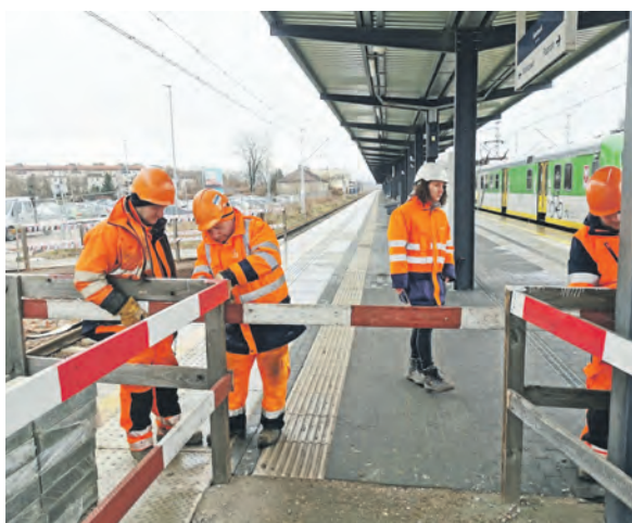
Definitywne zamknięcie przejścia na peron 1 przez budynek dworca. Teraz podróżni wchodzi na peron omijając remontowany budynek.
