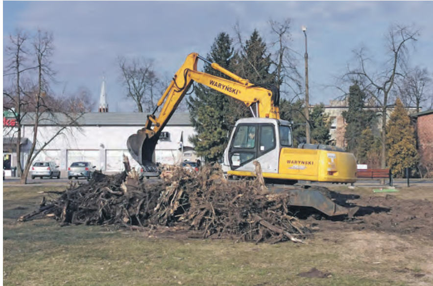
Koparka pracująca przy wyrwaniu z ziemi pni wyciętych drzew na skwerze przy ul. Starzyńskiego.
