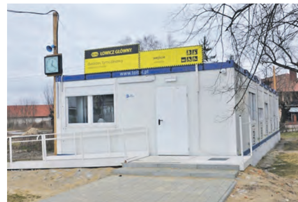
Tymczasowy dworzec kontenerowy wygląda niepozornie, położony jest po drugiej stronie ul. Dworcowej.
