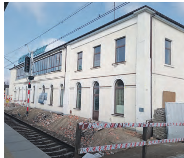
Wykonawca remontu dworca prowadzi m.in. wzmocnienie fundamentów budynku od strony peronów.
