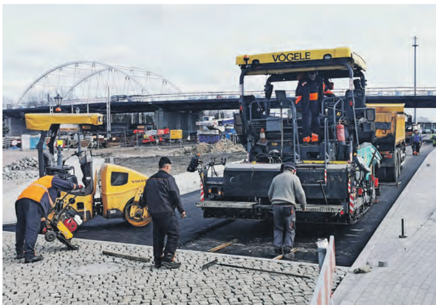
Rozścielacz do asfaltu w czasie pracy na ul. Napoleńskiej w Łowiczu.
