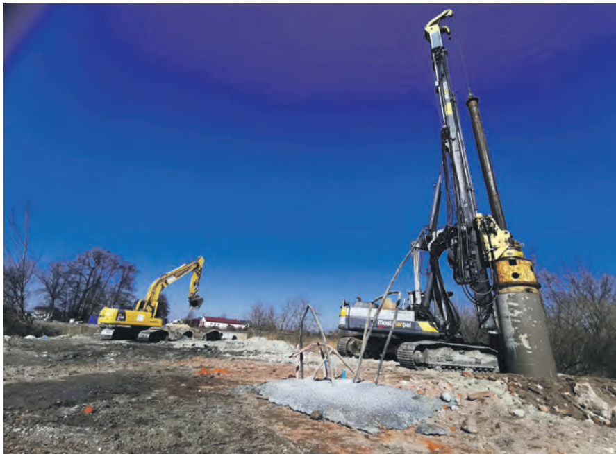
Plac budowy mostu w Kompinie. Po prawej stronie palownica umożliwiająca wykonanie żelbetonowych pali.
