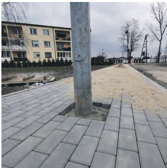
Latarnia stojąca pośrodku chodnika przy ul. Bolimowskiej.
