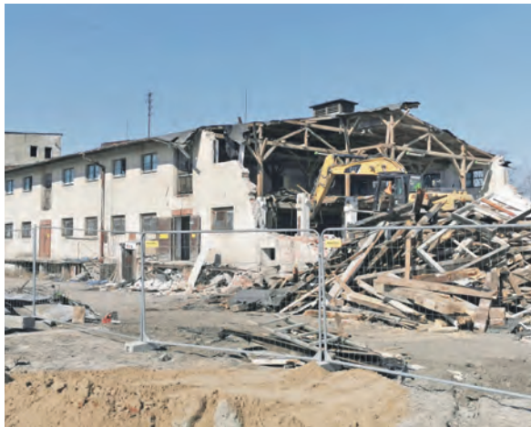
Wyburzanie budynku dawnego magazynu PZGS.
