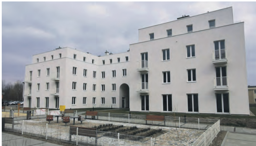
Jeden z trzech bloków wybudowanych przy ul. Krudowskiego w Łowiczu w ramach programu Mieszkanie Plus.
