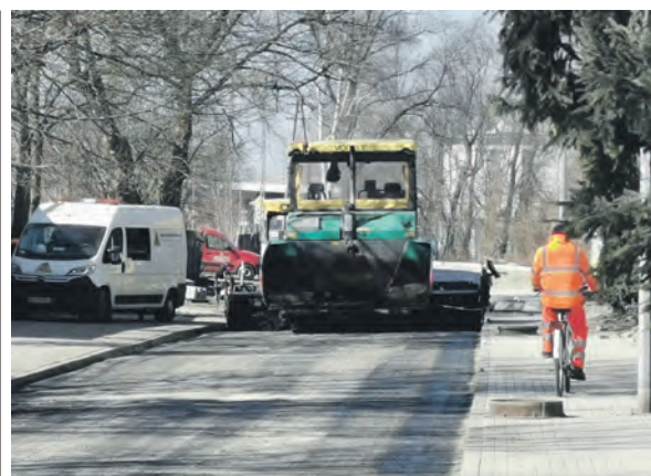
Rozścielacz układający asfalt na ulicy Nieborowskiej.
