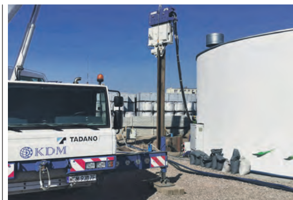
Głęboki otwór powstaje blisko ściany przepompowni.
