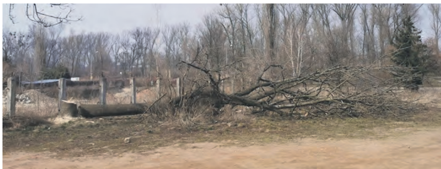
Wycięcie starych drzew na placu pod inwestycję wzbudziło pewne kontrowersje wśród mieszkańców, ale było legalne.
