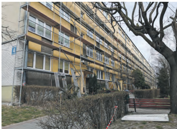
W sobotę, po jednym dniu prac, prawie cała wschodnia elewacja była już przykryta rusztowaniami.
