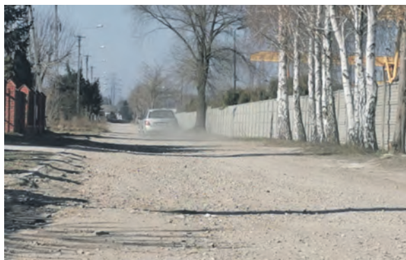
Ulica Czajki dziś pozbawiona jest asfaltu. Jego wykonanie jest uzależnione od zakończenia budowy kanalizacji sanitarnej.
