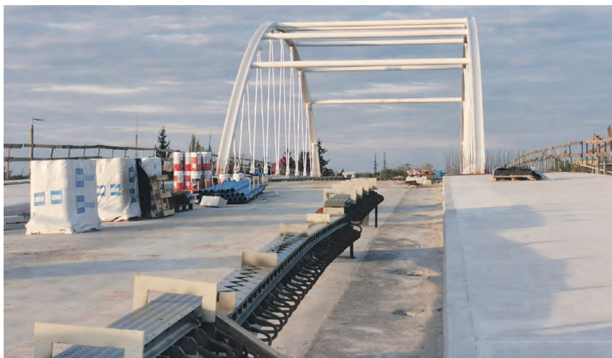
Na wiadukcie powstającym przy dworcu kolejowym Łowicz Główny widać przygotowane do wykonania nawierzchni chodniki i ciągi piesze. Cały czas trwa także układanie izolacji na wylanym betonie.
