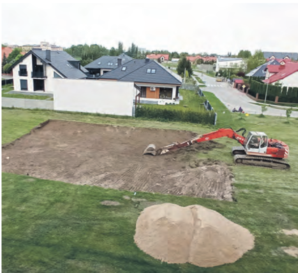
Na działce na osiedlu Bratkowice ruszyły prace przygotowawcze związane z budową „szeregowca”.
