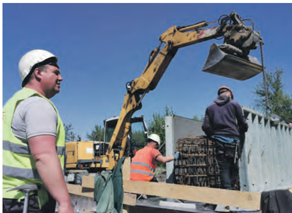
W ubiegłym tygodniu na placu budowy wykonywano zbrojenie oraz szalowanie podpór pod zalanie ich betonem.
