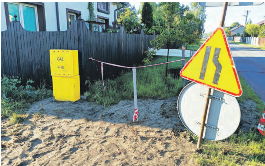
Prace w Wygodzie trwają od lipca zeszłego roku.
