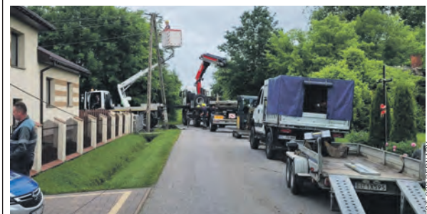
Zablokowana droga w Sypniu w czasie wymiany słupa energetycznego.
