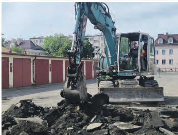
Firma Wig-Kost realizuje na zlecenie ŁSM budowę nowej nawierzchni przy garażach an os. Dąbrowskiego.
