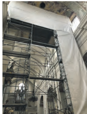
Prace konserwacyjno-restauracyjne obejmujące prezbiterium.
